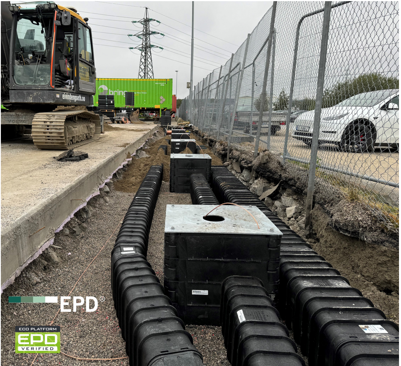
FF-kaivot latauspisteiden perustuksina ja QA MultiDuct kaapelin reititystä varten.
