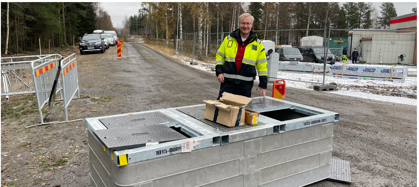
Lennart Rehnström, Regional Manager Melbyellä, oli mukana asentamassa Ultima Connect-kaivoa. Kuvassa latausaseman sähkönsyöttöaseman perusta, jossa on 3 sovituslevyä kansia ja laitteiston asennusta varten.
